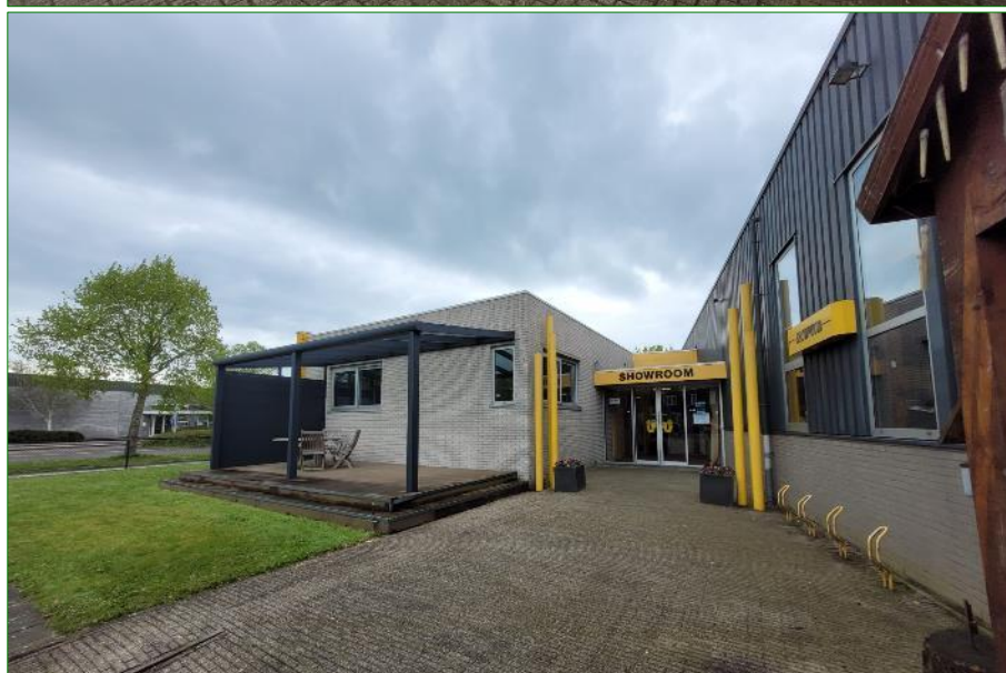
Overzicht van de bebouwing in het plangebied. Boven: oostzijde plangebied met voorgezette tegelwand. Midden: muren opgebouwd uit metalen platen. Onder: bakstenen muren bij de ingang met kleine overkapping
