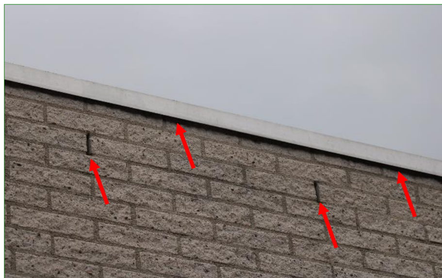
De openingen in de spouwmuur (rode pijlen) van de bebouwing geven mogelijk toegang tot voor vleermuizen geschikte achterliggende ruimtes.
