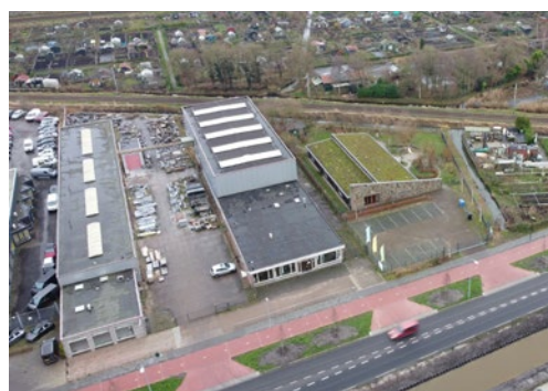
Zicht op het plangebied vanaf Berkhouterweg
