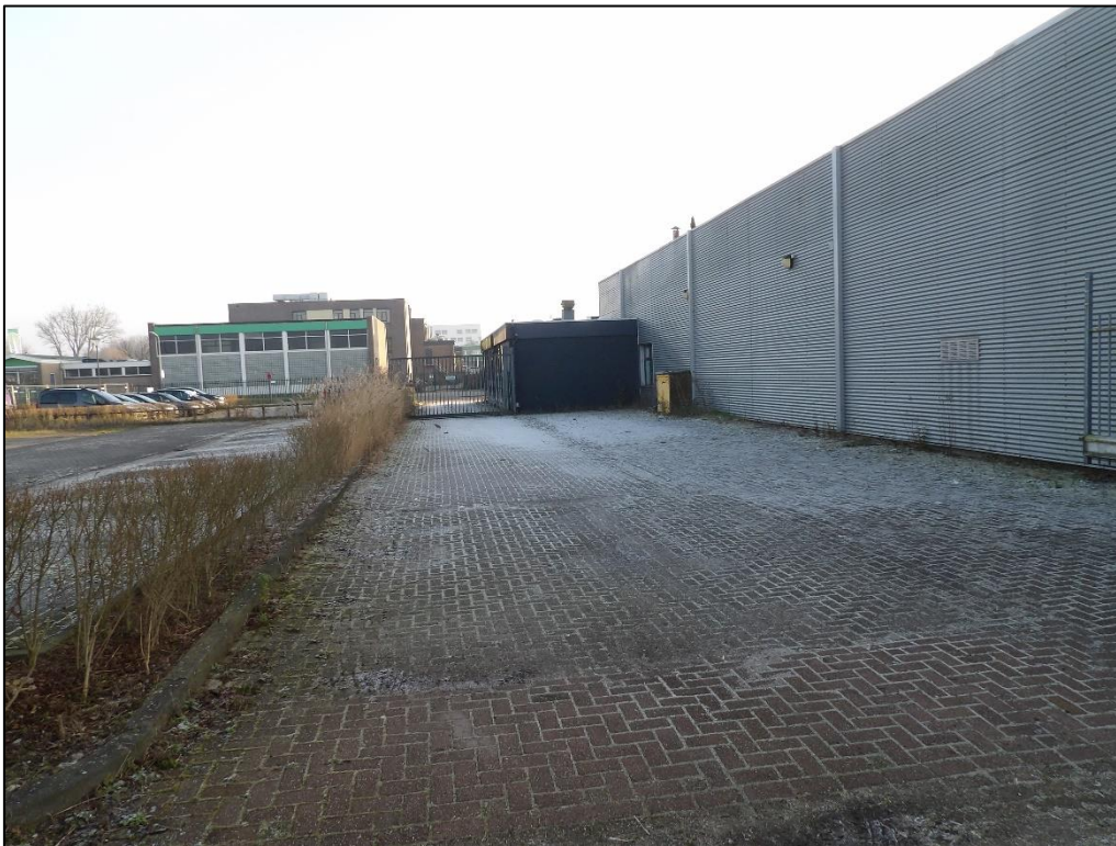
Figuur 12: De bedrijfspanden zijn opgebouwd uit metalen panelen. Vleermuizen hebben geen grip op metaal, waardoor geen verblijfplaatsen worden verwacht.
