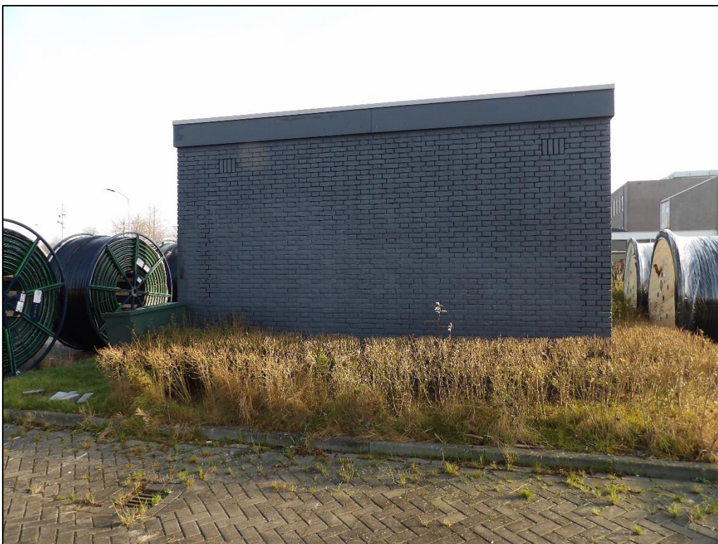
Figuur 13: Het transformator huisje binnen het plangebied met open stootvoegen. De directe omgeving van het transformatorhuisje is zeer goed verlicht door meerdere lantaarnpalen.
