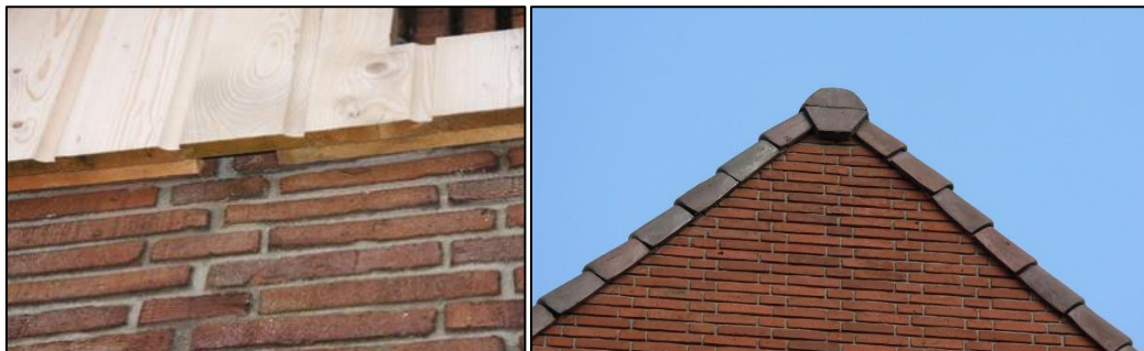
Figuur 3: Voorbeeld van toegankelijke boeiborden (links) en nokvorst (rechts) (Bron: bouwnatuurinclusief).
