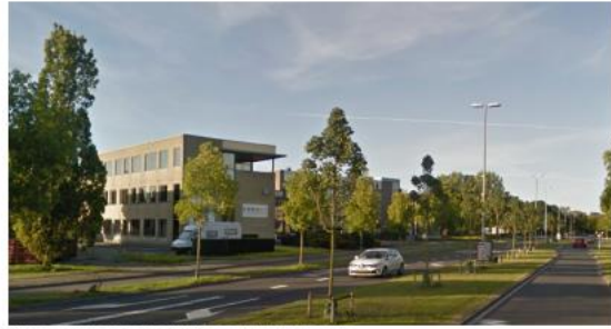
ZICHT OP HUIDIGE PAND VANAF DE ZWAAGMERGOUW
