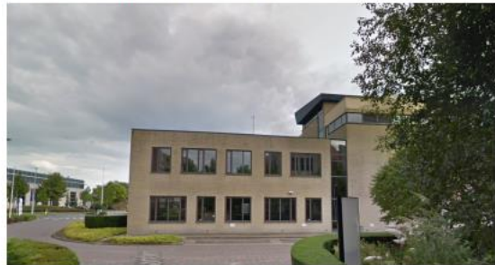
ACHERTERZIJDE HUIDIGE PAND VANAF DE KOOPVAARDER
