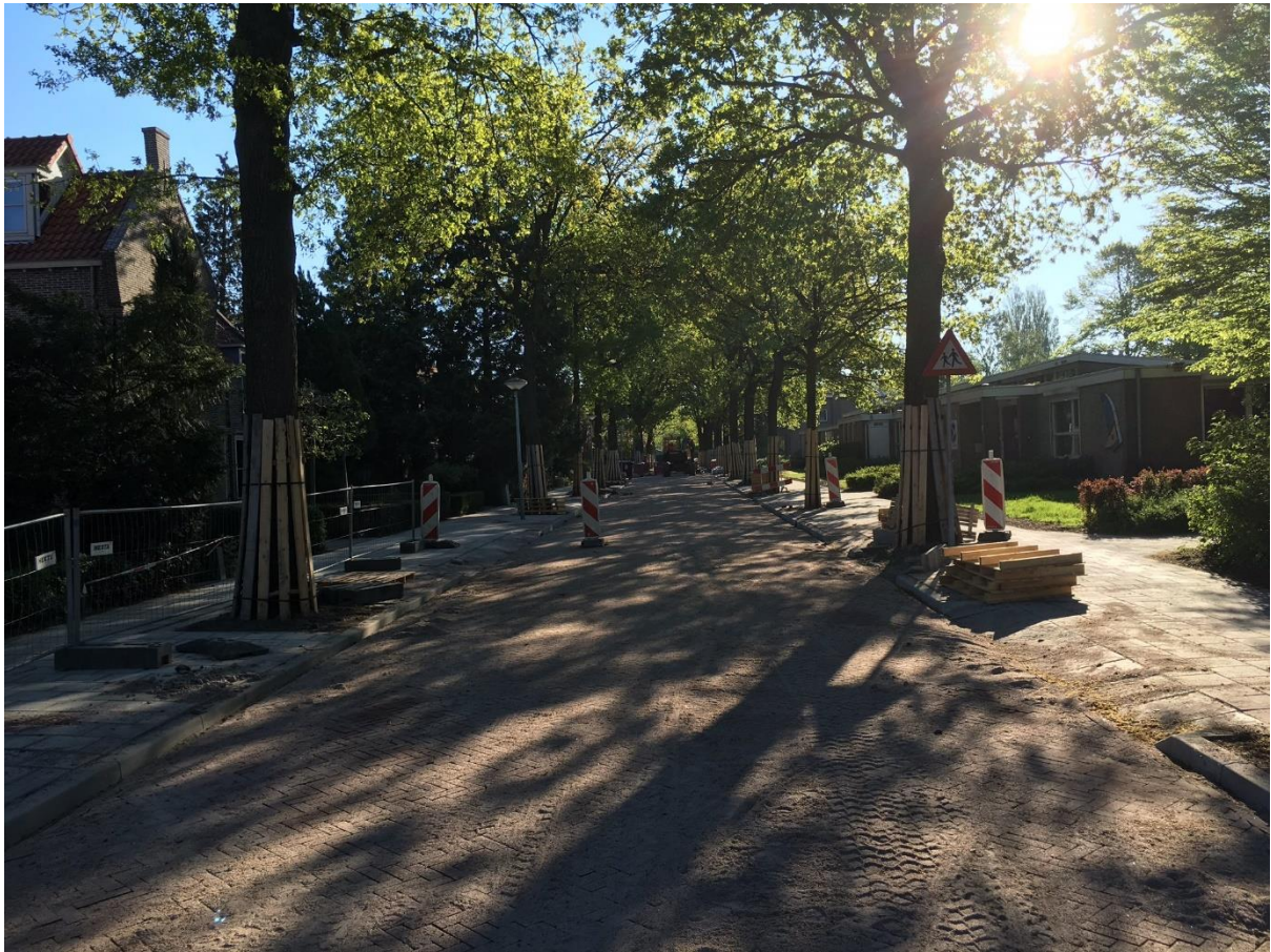
Figuur 1 Herbestrating Eikstraat (dankzij bewoners klinkers i.p.v. betonstenen)
