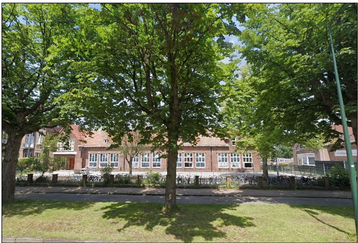
Afbeelding 2. School aan de Johan Messchaertstraat 1 (bron: Google Streetview).
