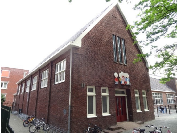
Buitengevels van de gymnastiekzaal
