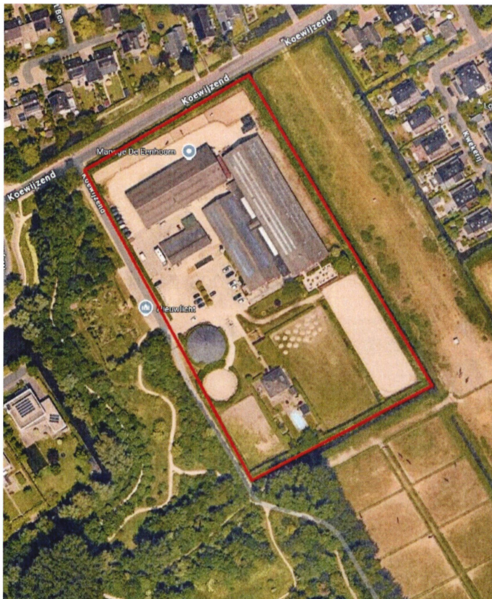
Projectlocatie Manage De Eenhoorn aan de Koewijzend 32.
